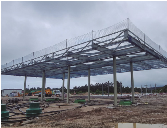
Estación de Servicio en Autovía del Cantábrico de Ingeco, S.L. A Ronda (Asturias)
