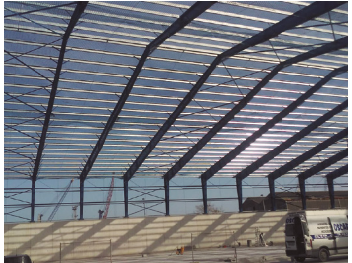
Nave en Puerto de Avilés de Cubreastur, S.L. Avilés (Asturias)
