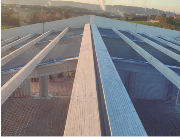
Excavaciones Paúl de Cubreastur, S.L. Gijón (Asturias)
