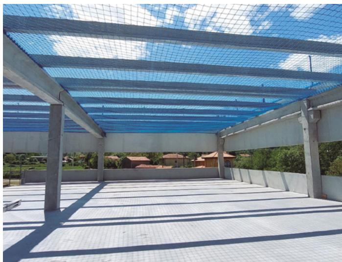
Oficinas Andros La Serna de Siecsa Construcciones y Servicios, S.A. La Serna (Cantabria)
